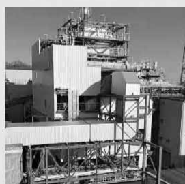
ボイラー本体
